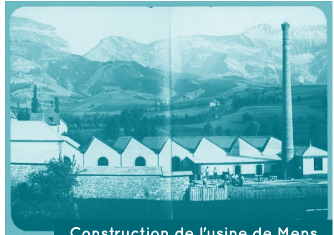
Construction de l'usine de Mens
